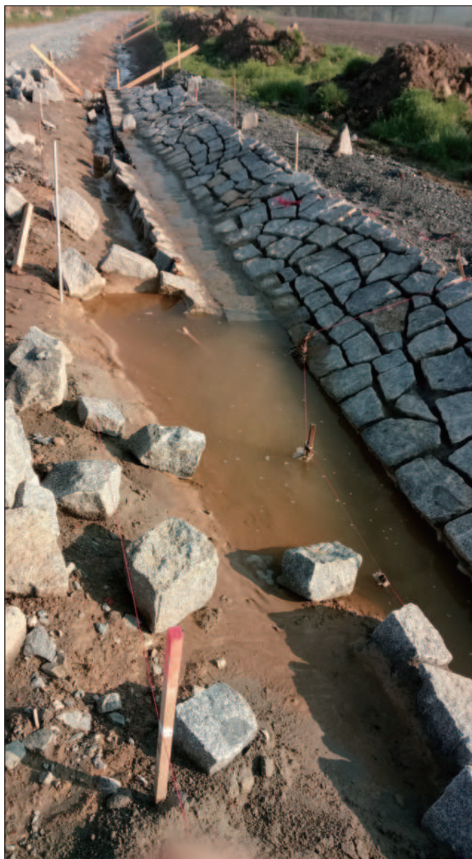
Místo erozní události z 6. 6. 2017 po jedenácti letech funkce záchytného cestního příkopu a zasakovacího ochranného travního pásu nad vybudovanou cestou rozdělující půdní blok orné půdy. Toto polyfunkční společné zařízení bylo navrženo v plánu společných zařízení. Realizátor polní cesty pobočka Krajského pozemkového úřadu v Plzni a velkoplošný uživatel zatravněného pozemku (foto 27. 4. 2022).
