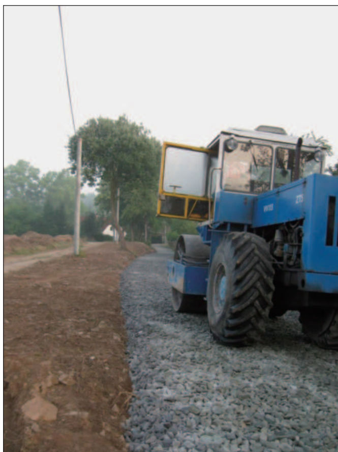
PŘEHUTNĚNÍ VRSTVY KAMENIVA
