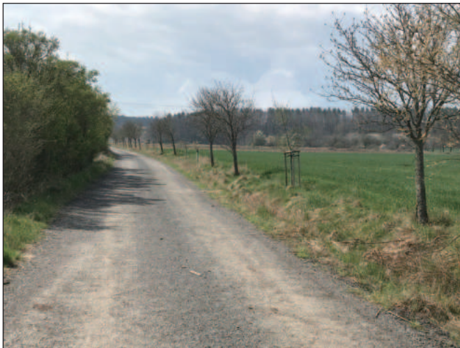
Druhá polní cesta z roku 1993 s již modernizovaným krytem z prolévaného makadamu. Stromořadí poničené vandaly je doplněné ovocnými stromy. Tato cesta byla po dvaceti letech propojena na nově vybudovanou polní cestu v Želčanech a došlo ke komunikačnímu propojení obcí (foto 22. 4. 2022).
