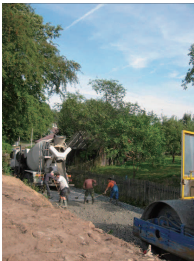
PROLÉVÁNÍ A ROZPROSTÍRÁNÍ SUSPENZE
